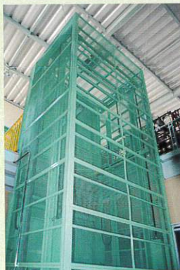
エキスパンドメタル張り昇降路
